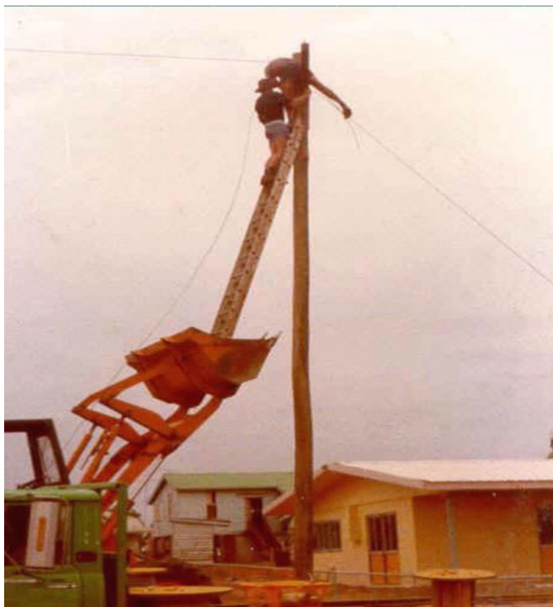
شکل ۱-۳- عدم رعایت ایمنی در برقرسانی کارگاهی و بالا رفتن از نردبان
