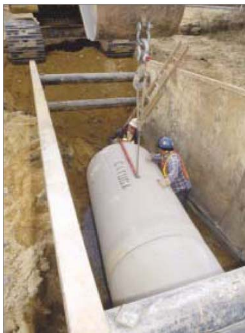
شکل ۳-۱- رعایت ایمنی در حفاری ترانشه
